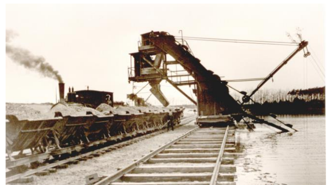
Sandförderung mit Bagger, Verfahren mit Zügen (Archiv Kahl) Bild 4 (oder 2)
